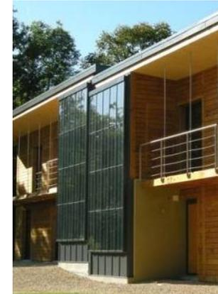
En été, au contraire, les apports solaires doivent être réduits au maximum. Pour ce faire, une avancée du toit, un brise soleil, ou même de simples stores permettent de limiter grandement l'effet de surchauffe.
