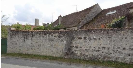
La cohérence et continuité entre le mur d'enceinte « conservé » et rétabli sont assurées par l'emploi d'un même type d'appareillage ( à l'exception de l'épaisseur), caractérisé par l'alternance d'assises de grès équarris et d'assises de moellons plus grossiers.
