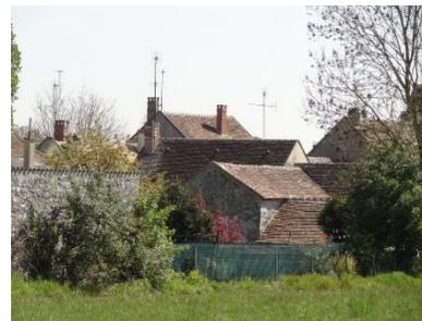
Les toitures à deux pentes d'environ 45°, voire 55° ou plus pour les constructions médiévales comportent peu de lucarnes et châssis de toit et sont couvertes de tuiles plates souvent anciennes. La présence de croupe reste exceptionnelle. Les toitures débordent faiblement du mur gouttereau et s'arrêtent au nu du mur pignon.
