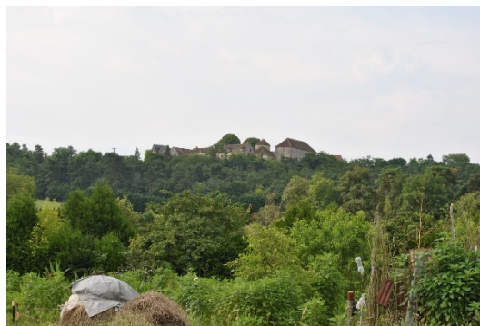
Vue depuis le village sur la ferme du Chapitre
