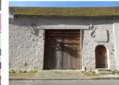
Site de l'ancienne Chapelle Saint - Mathurin
