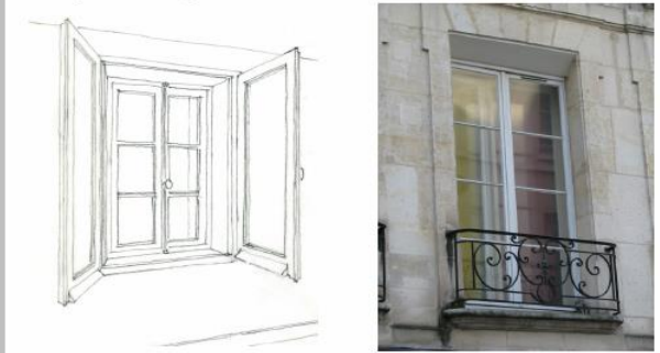
La technique de la double fenêtre est courante dans les régions froides, notamment en montagne
