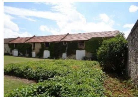
La longue aile sud ouest, vue de de la cour, d'environ 720 m 2 (emprise au sol).
