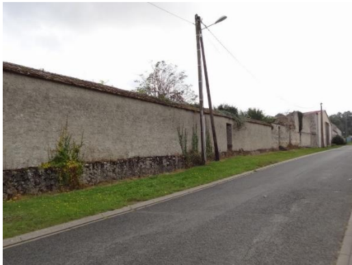
Les vestiges du mur d'enceinte rue des Fossés Larry
