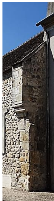
L'encorbellement, indice d'une structure à pan de bois
