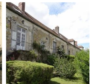
La façade nord-est de la ferme a subi d'importantes modifications au début du XX ème siècle.
