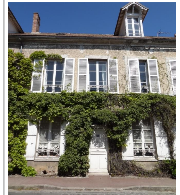
Les menuiseries de fenêtre et les volets pleins en rez de chaussée et les volets persiennés à l'étage composent fortement le dessin de la façade.
